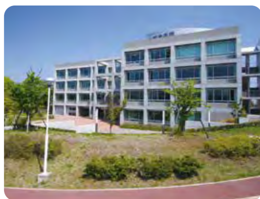
2 エアコン完備の総合教育棟
