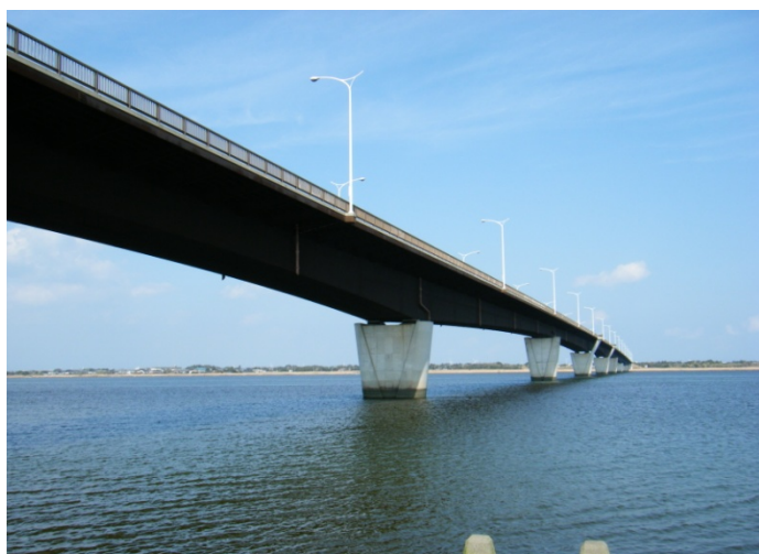
写真-1 利根川に架橋された耐候性鋼橋
