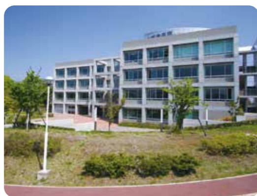
2 エアコン完備の総合教育棟
