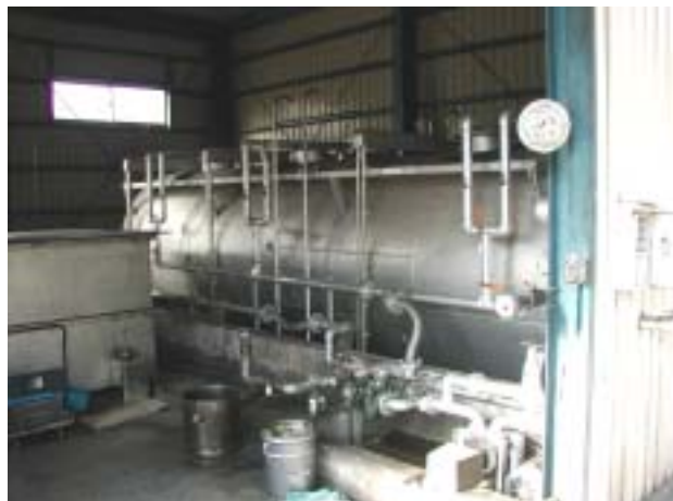
油水分離装置
