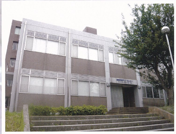
研究協力の活動拠点となる「地域共同テクノセンター」 (平成13年3月竣工)
