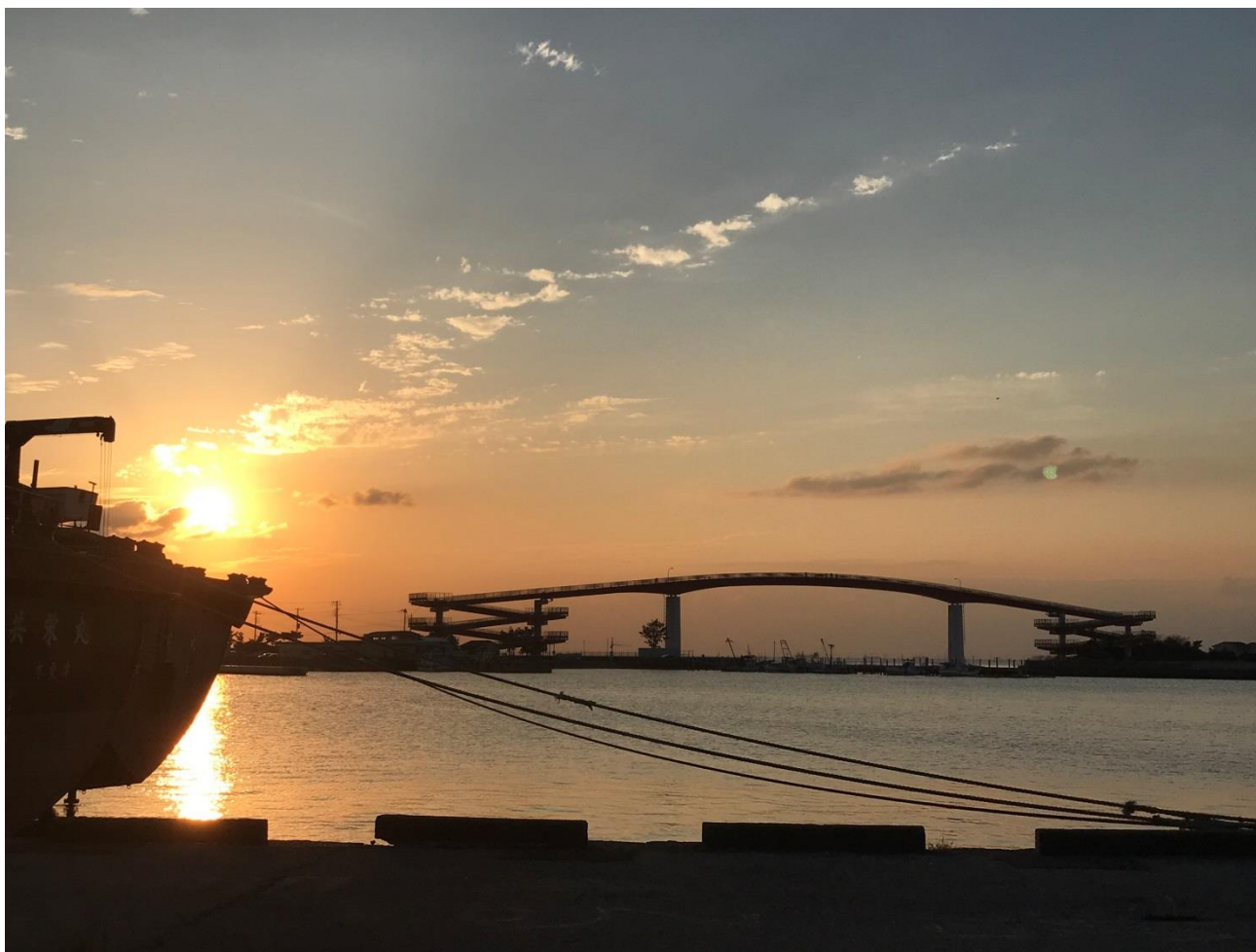
木更津港と中の島大橋の夕日 撮影：松本義一
