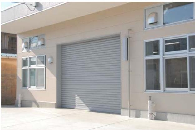
機械工場の東側出入口は大型設備や大きな材料の搬入に便利なシャッター構造。電動式で開閉することができます。
