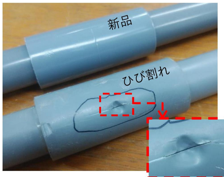
図1 塩ビ管継手のひび割れの例
