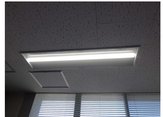
照明器具の交換（LED化）
